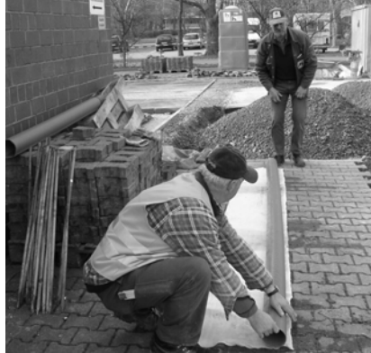
Die Bauarbeiter dichten Abflussrohre für das Sickerwasser ab: Eine Maßnahme, damit der Platz auch nach Jahren bei Unwetter nicht absäuft
