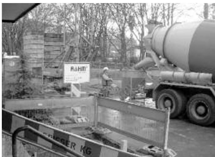
Die vorübergehende Baustelle vor dem Bürgerhaus
