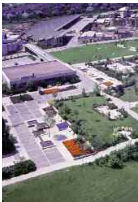
Bild 2: Der Grünzug vom Hochhaus Wallensteinstraße 33-37 bis zur Brücke zum Kaufpark
