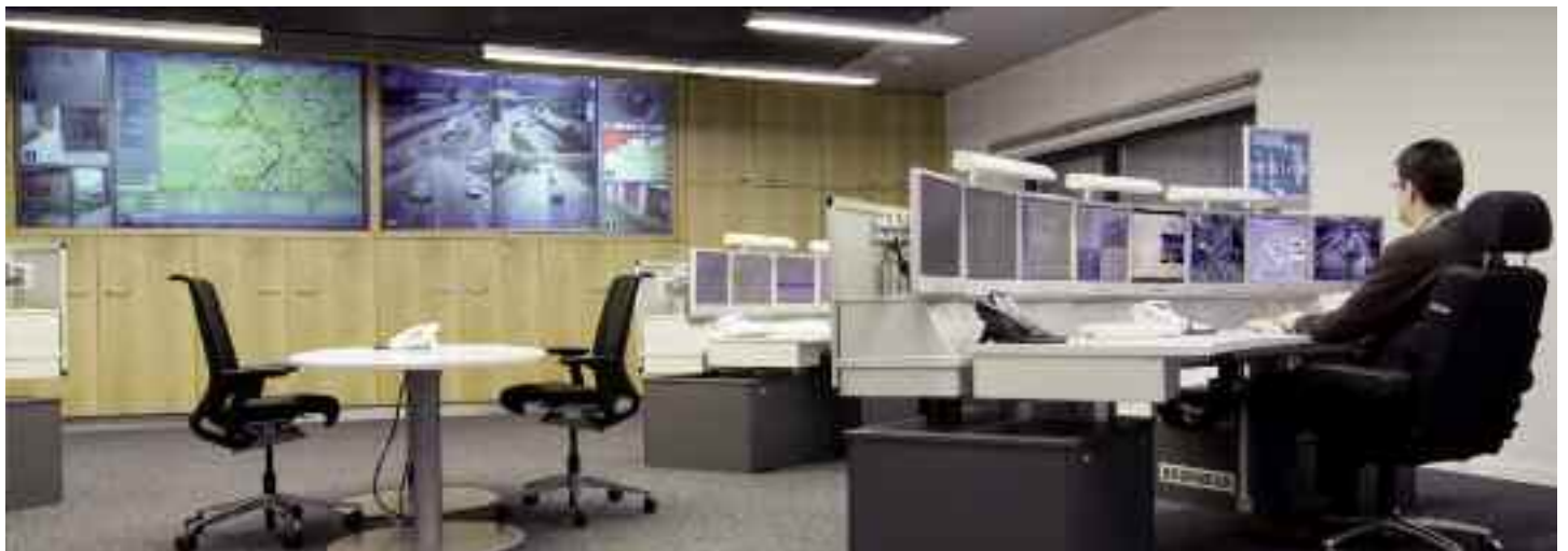
Blick in die Integrierte Verkehrsleitzentrale (IVLZ) in Cannstatt
