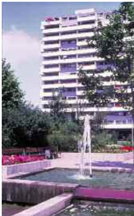
Bild 1: Die Sprudler vor dem Hochhaus Wallensteinstraße 29/31
