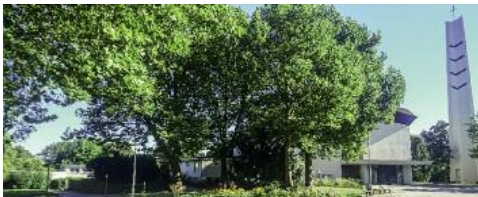
Die kath. Kirche Mönchfeld, Seitenansicht mit Nebengebäuden
